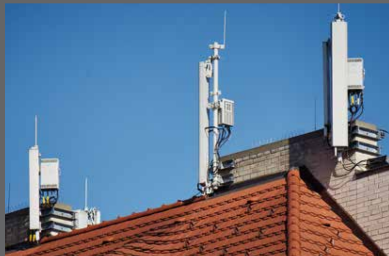
Antény mobilního operátora na komínovém tělese
