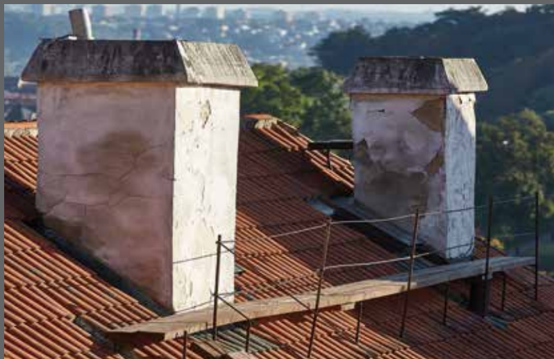
POZITIVNÍ PŘÍKLADY UMÍSTĚNÍ A ŘEŠENÍ KOMÍNOVÉ LÁVKY
