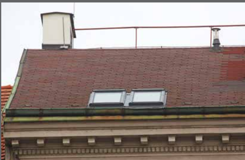
Původní keramická krytina nahrazena střešním asfaltovým šindelem
