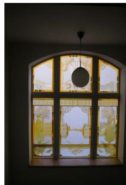
leptaná skla – doplnění původních novými
