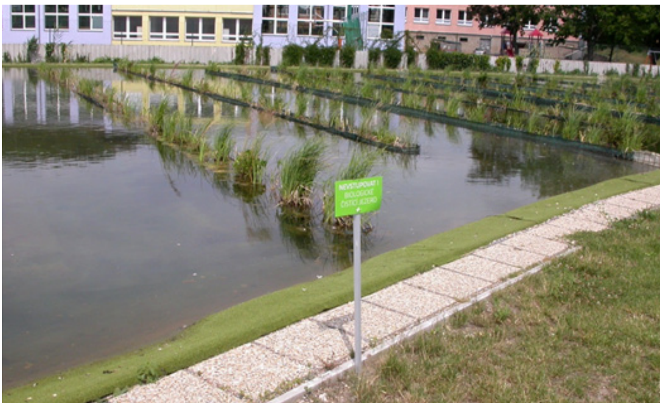
Obr. C3.3: Přírodní způsob čištění vody na koupališti v Radotíně
