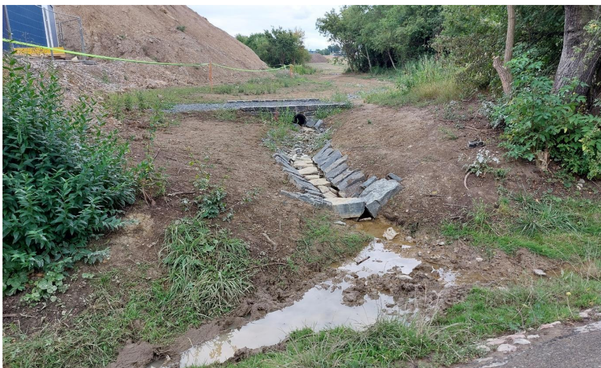
Obr. č. 3 Pohled na propustek DN400, ř. km 1,021
