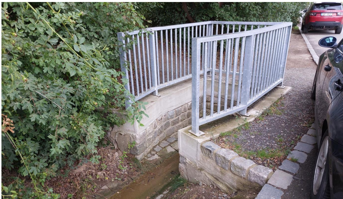
Obr. č. 2 Vtok do zatrubnění ř. km 0,99
