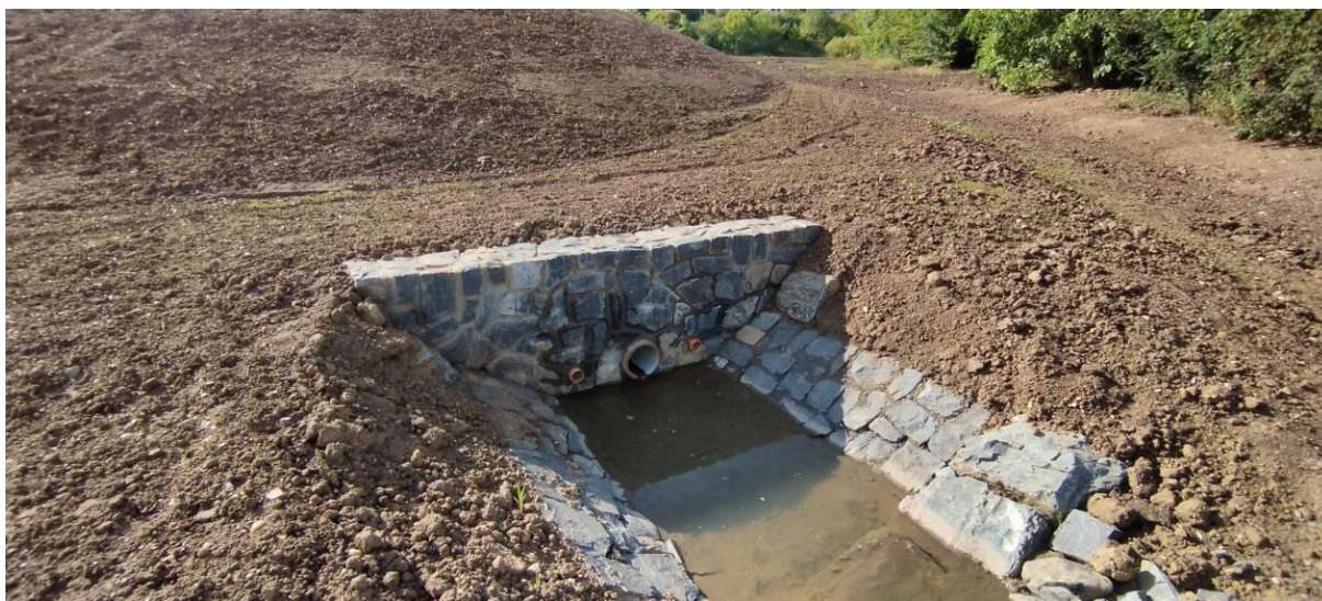
Obr. č. 6 Pohled na výtok ze suché nádrže
