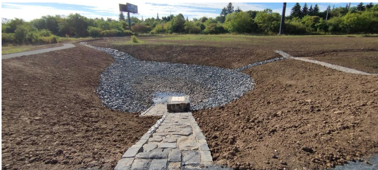
Obr. č. 5 Pohled do suché nádrže z hráze, napravo bezpečnostní přeliv lichoběžníkového tvaru, nalevo nátok do suché nádrže
