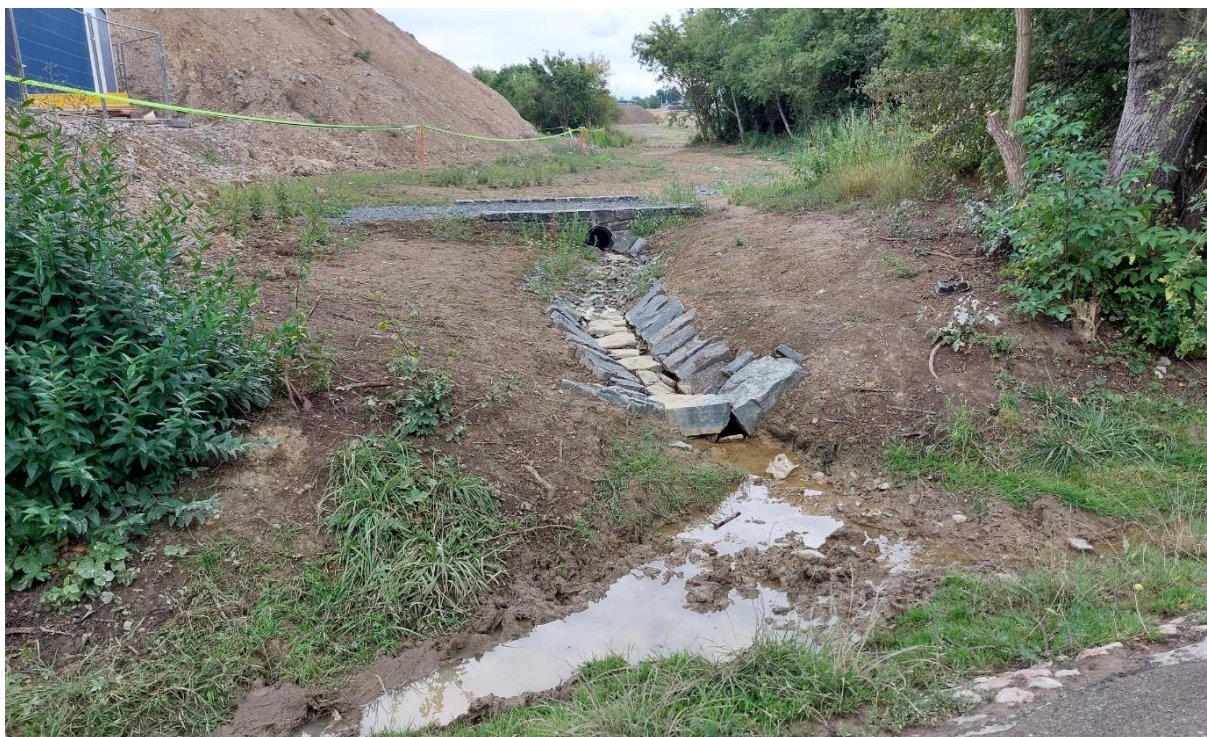
Obr. č. 3 Pohled na propustek DN400, ř. km 2,021
