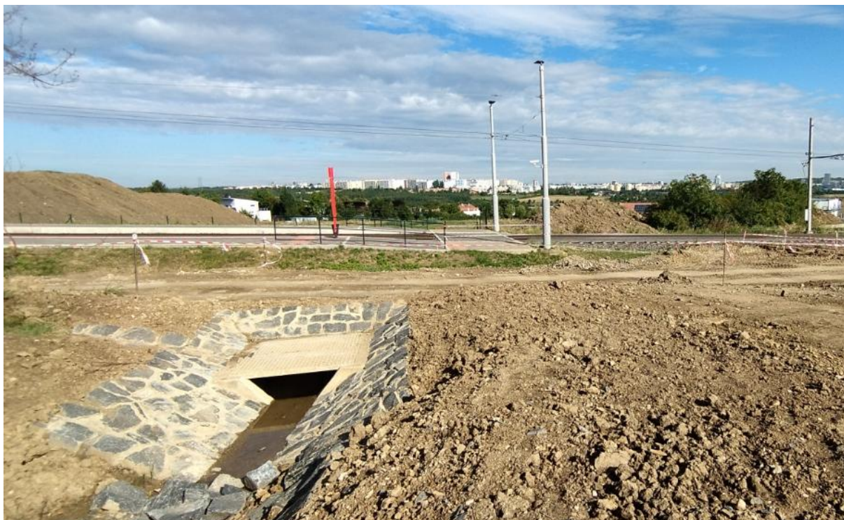
Obr. č. 7 Pohled na nátok do propustku pod tramvajovým pásem
