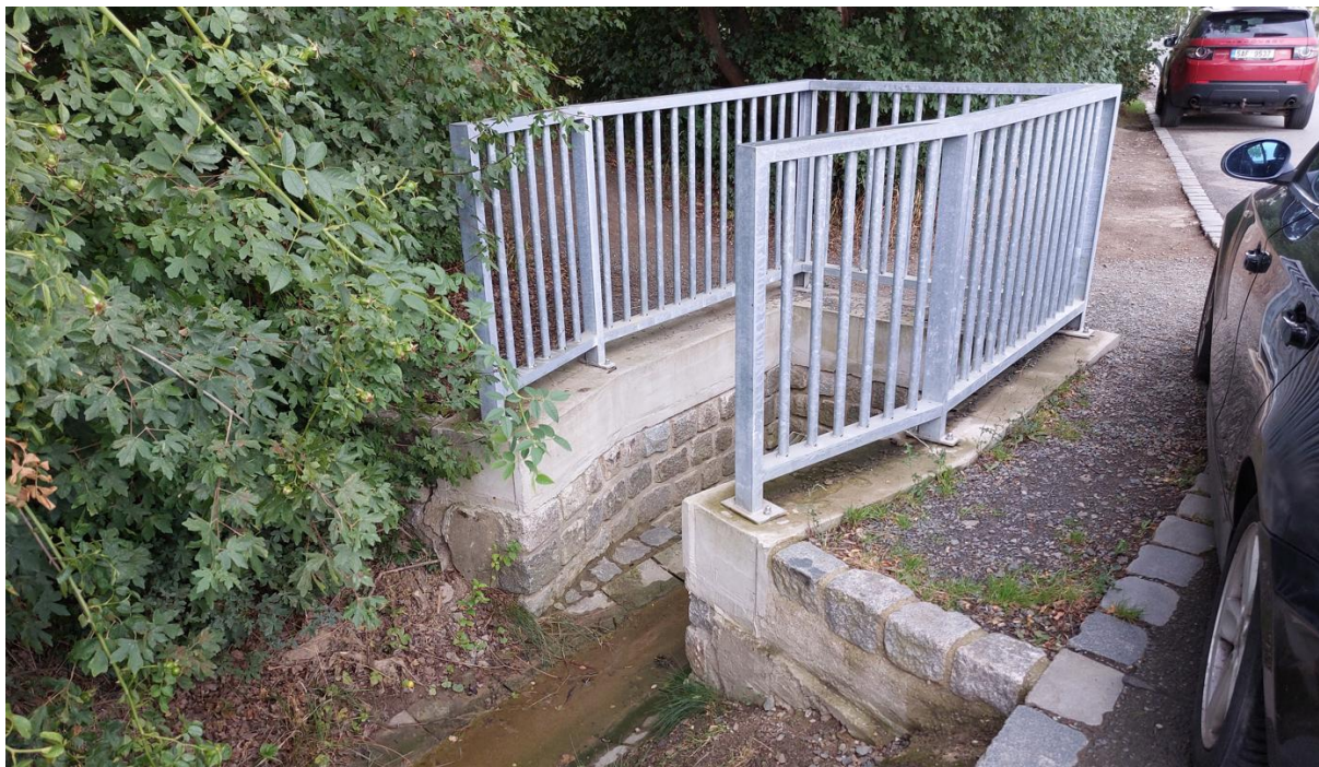
Obr. č. 2 Vtok do zatrubnění ř. km 1,99
