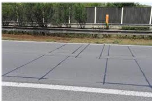
Obrázek 2 Indukční smyčka; Zdroj: https://mapy.plzen.eu/big-data-z-dopravnich-detektoru-davaji-informace-o-intenzite-dopravy/
