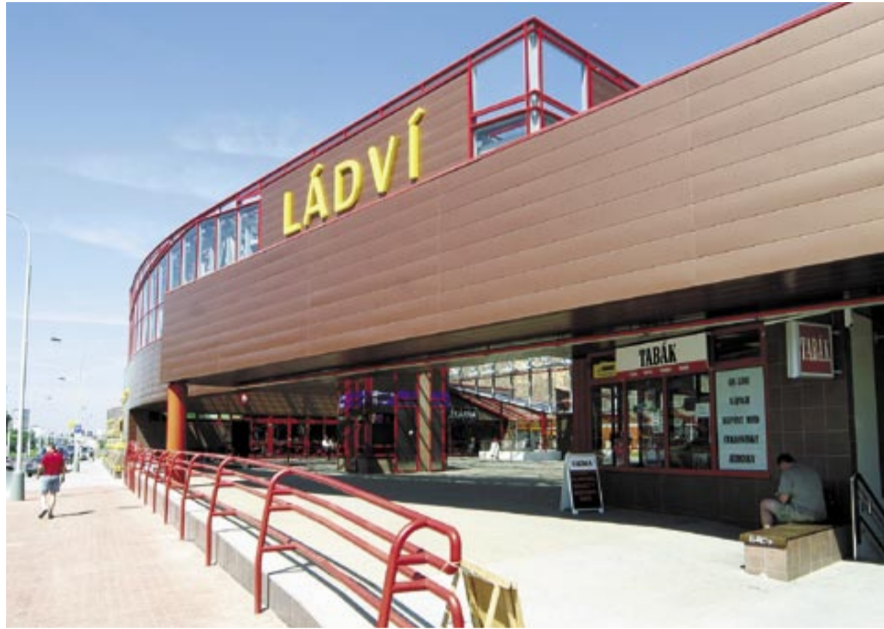
STANICE LÁDVÍ. Moderní stanice pražského metra slouží cestujícím od června loňského roku.
