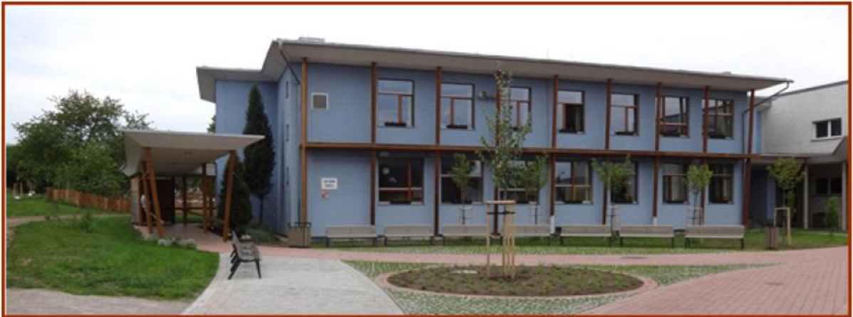
Obr. 29: Pasivní a nízkoenergetická Základní škola a mateřská škola Praha-Slivenec s extenzivní zelenou střechou a polopropustnou dlažbou. (Zdroj: http://www.skolaslivenec.cz/. )
