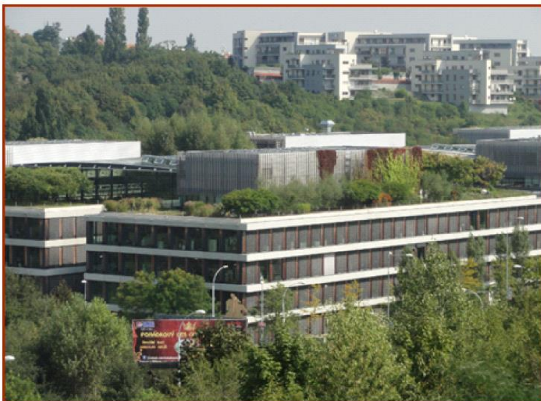
Obr. 28: Intenzivní zelená střecha a vegetační zastínění a další úsporná zařízení na budově ČSOB Radlická. (Zdroj: http://www.csob.cz/cz/Csob/O-CSOB/Budova-CSOB-Radlice/Stranky/default.aspx .)
