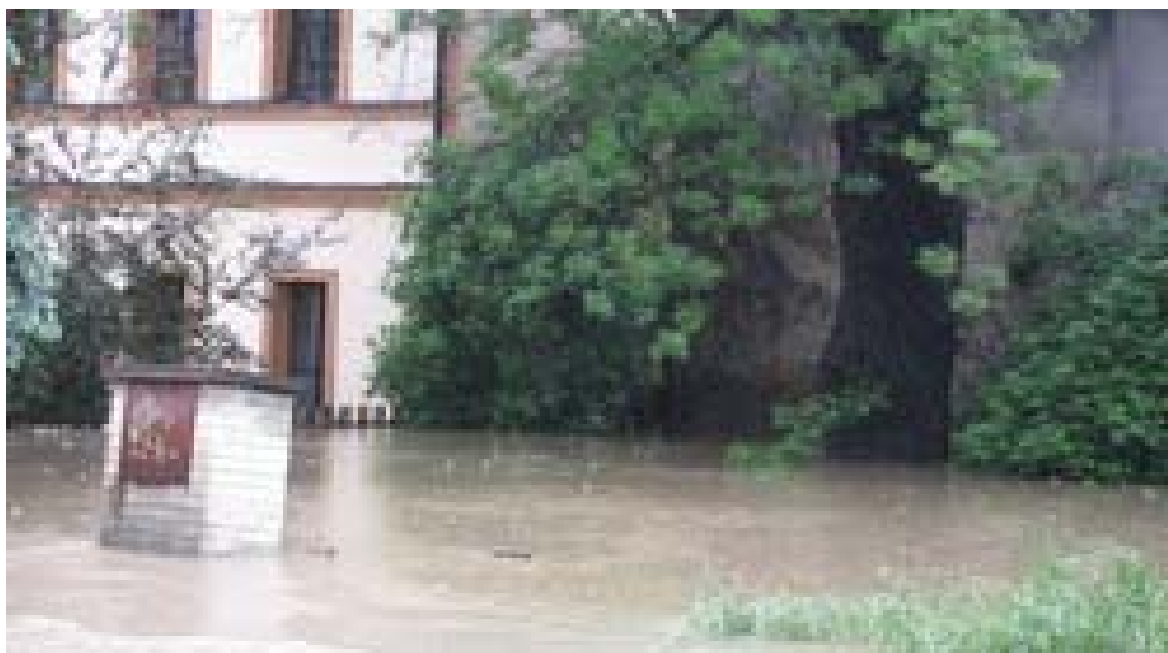
detail zaplaveného objektu
