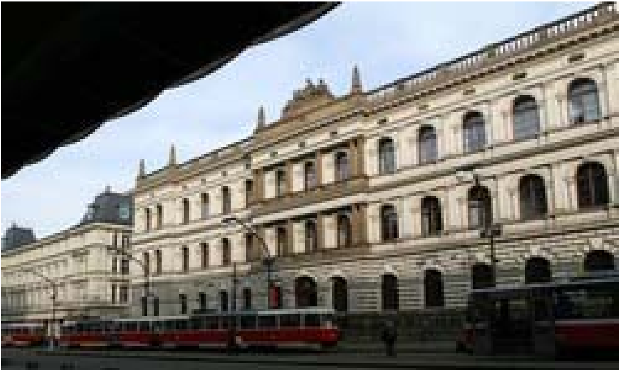
celkový pohled na budovu
