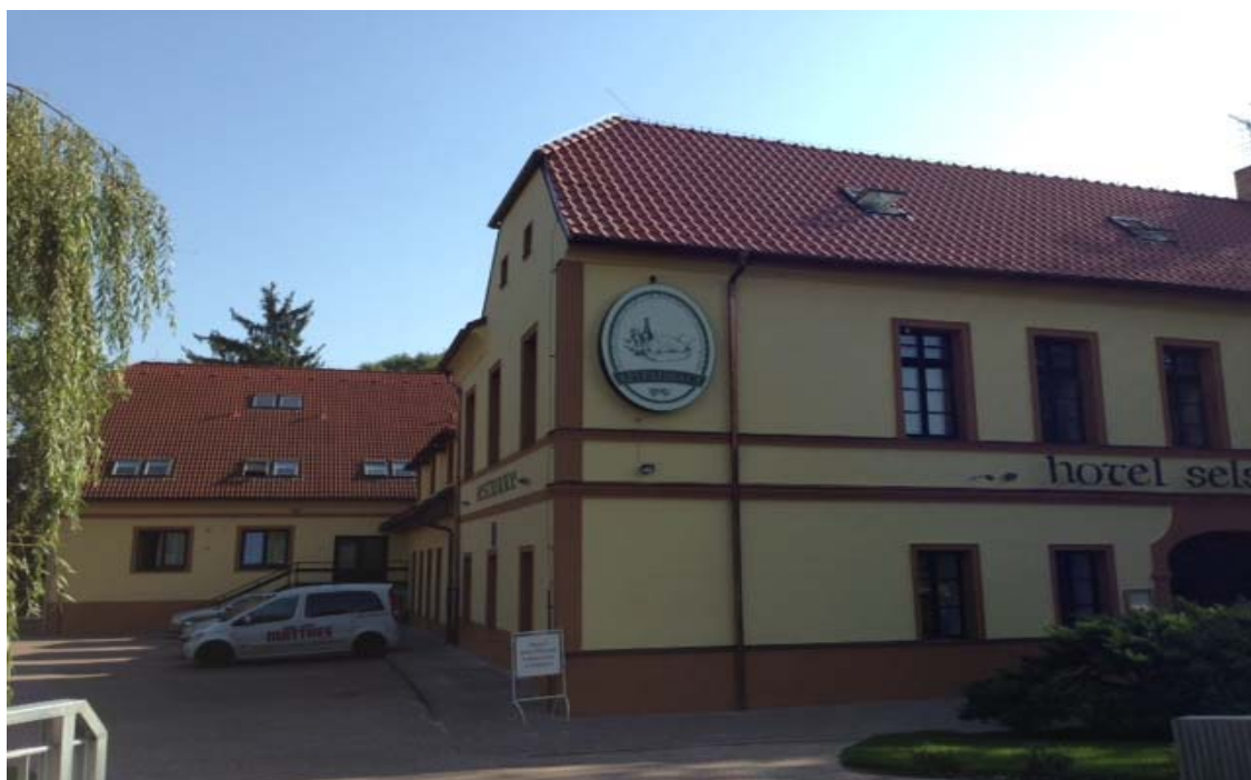
celkový pohled na objekt po opravě
