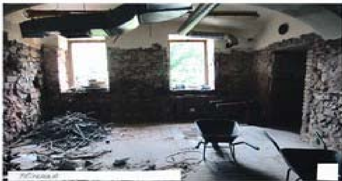
detail z průběhu oprav objektu - vnitřní omítky
