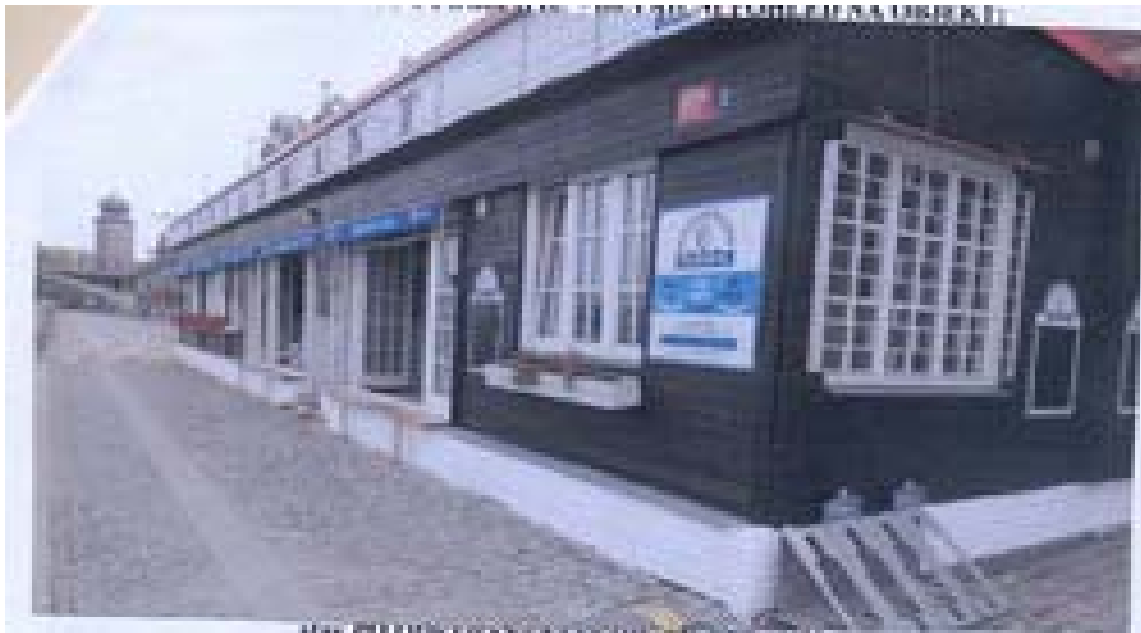
stav po opravě
