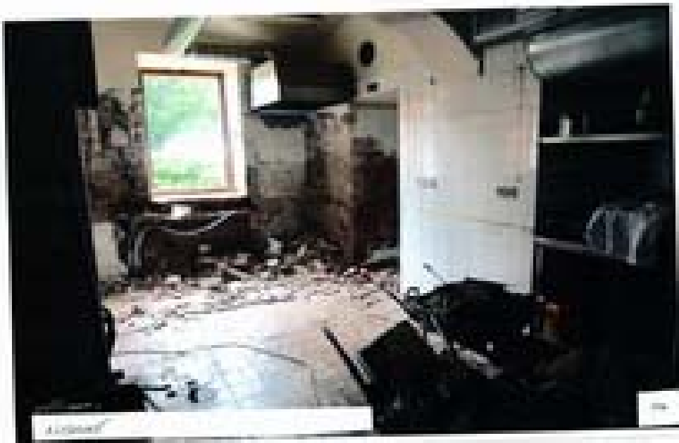
detail z průběhu oprav objektu
