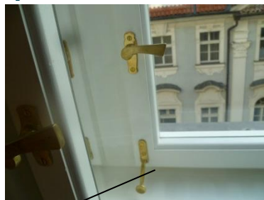
detail zrepasované kličky u okna a dveří
