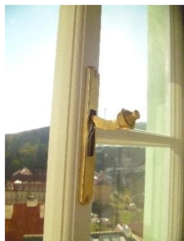
detail zrepasované kličky u okna a dveří
