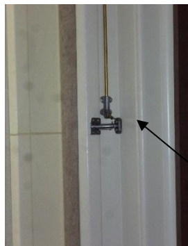
detail zrepasovanéh o táhla u okna
