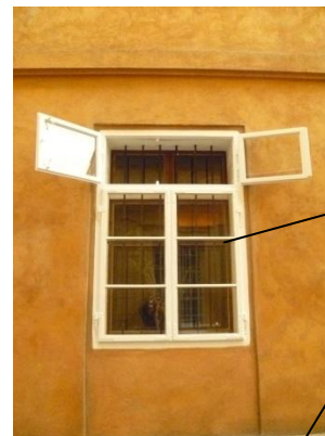
okno po repasi
