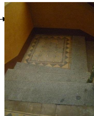
restaurován í schodů a podest
