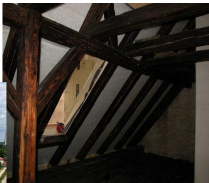
oprava střešní konstrukce - krov
