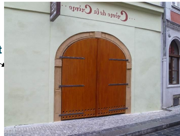
detail restaurování vstupních vrat – kovářské práce
