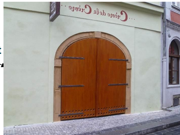
detail restaurování vstupních vrat – kovářské práce
