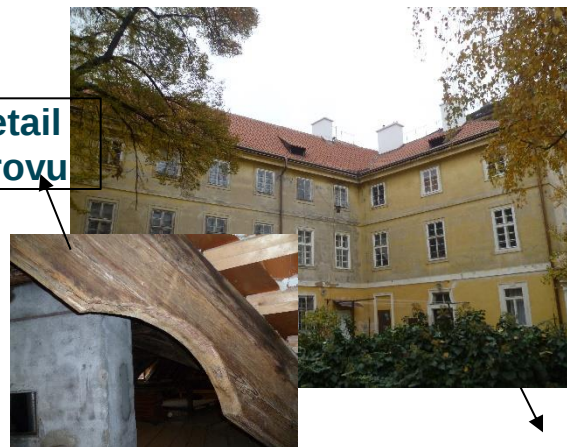
nová střešní krytina
