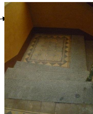
restaurován í schodů a podest
