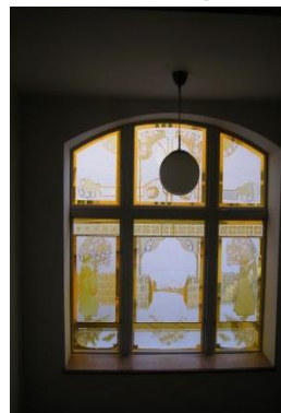
leptaná skla – doplnění původních novými
