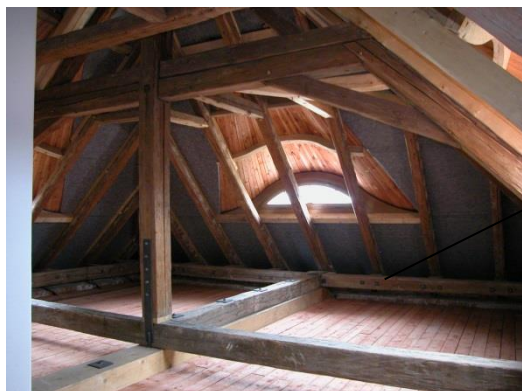
oprava střešní konstrukce - krov
