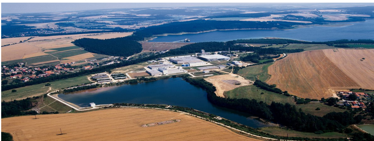
Obr. B2.2.7: Úpravna vody Želivka a vodní nádrž Švihov
