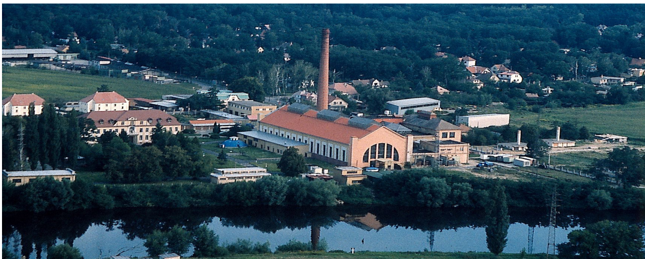
Obr. B2.2.6: Úpravna vody Káraný
