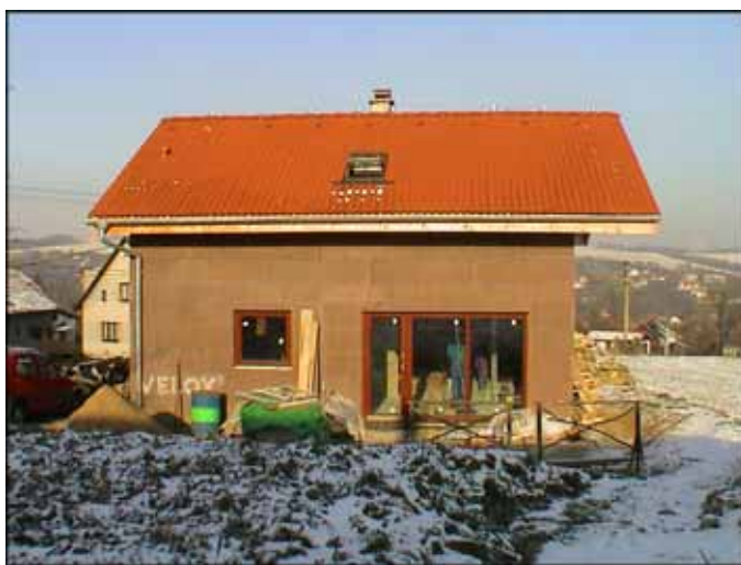
Obrázek č. 35 – Budování demonstračního nízkoenergetického domu.
