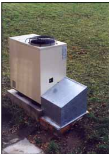
Obrázek č. 29 – Tepelné čerpadlo vzduch/voda.
