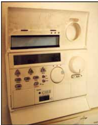
Obrázek č. 10 – Programovatelná jednotka ekvitermní regulace.
