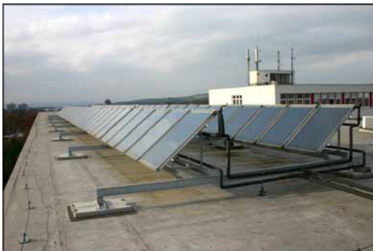
Obrázek č. 24 – Solární termické kolektory sloužící k ohřevu teplé užitkové vody v SPŠ Zlín.
