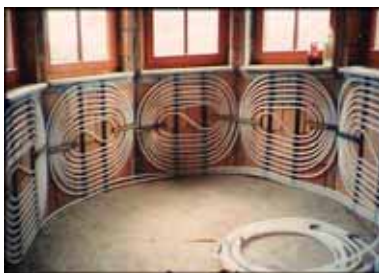
Obrázek č. 15 – Stěnové topení před nanesením vnitřních omítek.
