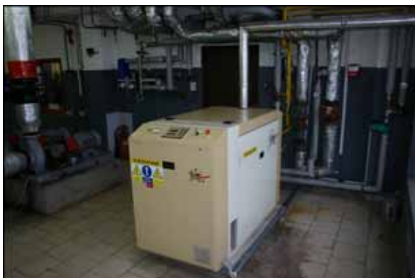
Obrázek č. 32 – Kogenerační jednotka na skládkový plyn v TKO Kroměříž.
