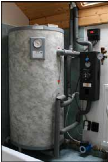
Obrázek č. 12 – Trivalentní zásobník na TUV se solárním ohřevem.
