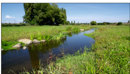
Revitalizace Říčanského potoka pod Litoznicí
