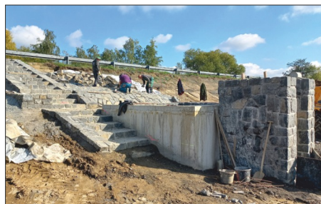
Z průběhu revitalizace retenční nádrže Rezerva v Kunraticích
