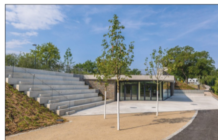
Nové bistro v parku na Vítkově se střešní zahradou (zelenou střechou)
