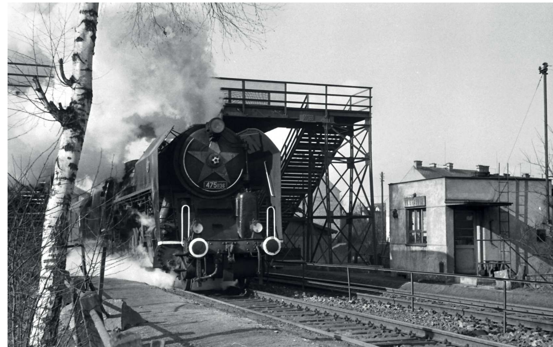
5/ PRAHA-ŠTRAŠNICE, ZASTÁVKA, 18. ÚNORA 1968. POD LÁVKOU ZASTÁVKY BYLO HRADLO PRO ŘÍZENÍ PROVOZU. PO POKLESU DOPRAVY BYLO 15. PROSINCE 1992 ZRUŠENO.
