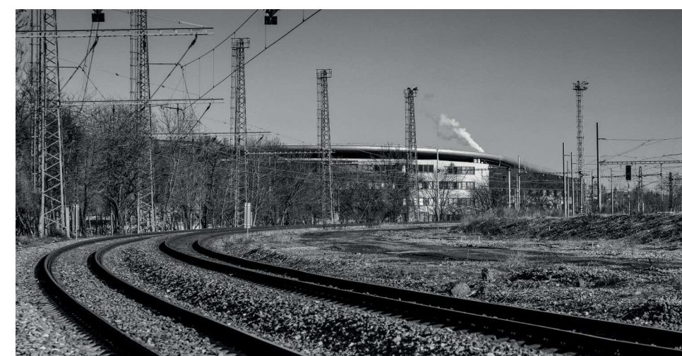
OSVĚTLOVACÍ VĚŽE S KRAKORCI – MEZI ULICEMI MOSKEVSKÁ A U SLÁVIE
