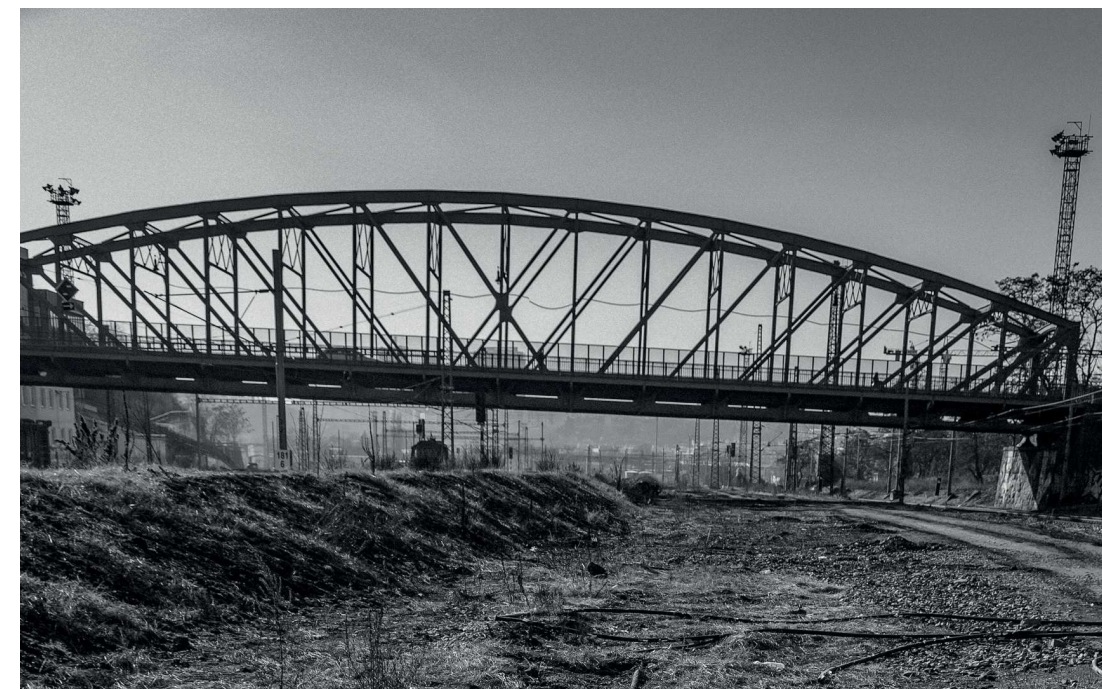
ŽELEZNIČNÍ MOST – MOSKEVSKÁ
