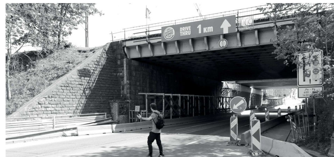
MOST PŘES ULICI U SLÁVIE (U EDENU) Z ROKU 1941, OCELOVÁ NÝTOVANÁ KONSTRUKCE
