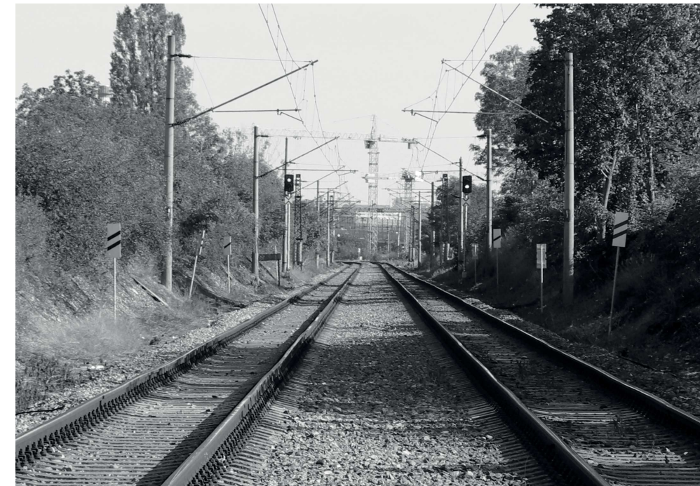
KOLEJIŠTĚ S TRAKCEMI
