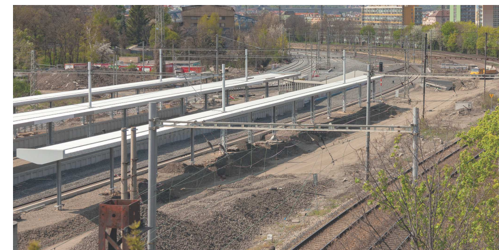
ZASTÁVKA PRAHA - EDEN, PROBÍHAJÍCÍ STAVBA
