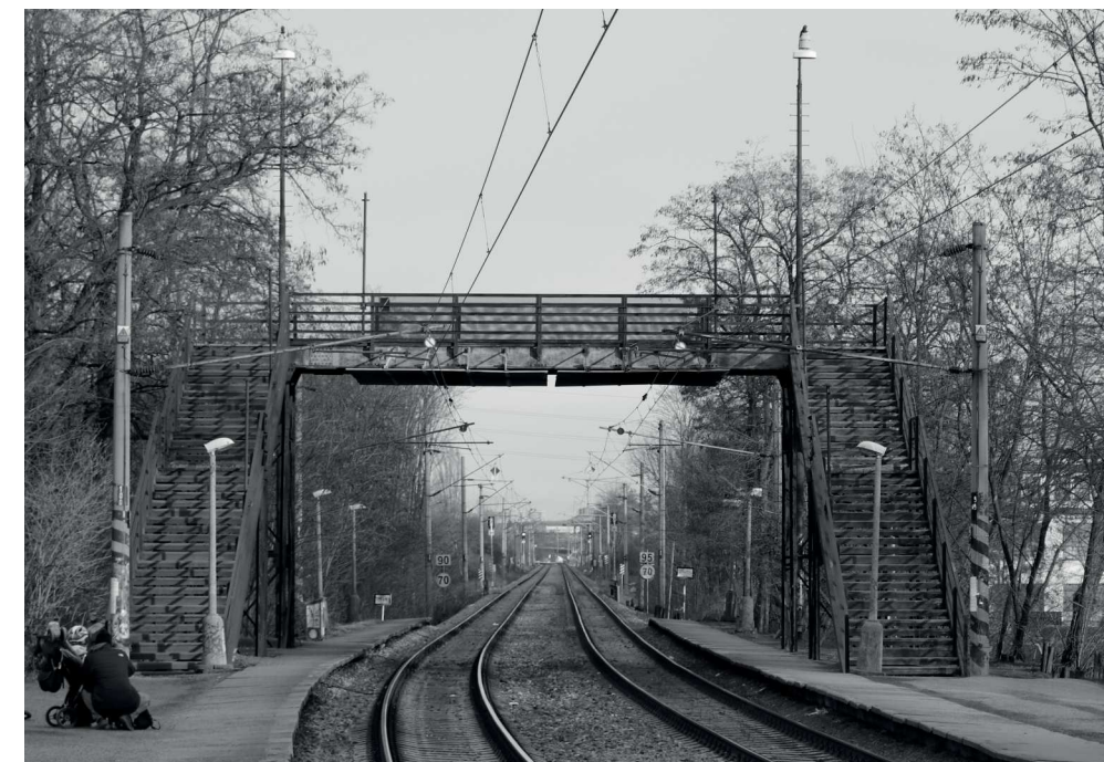
LÁVKA V ZASTÁVCE STRAŠNICE – CCA Z ROKU 1934
