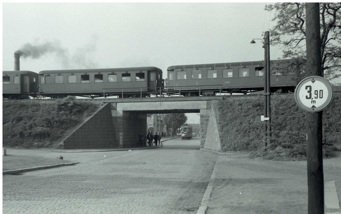
1/ PODJEZD ULICE V KORYTECH, PŘED ROKEM 1968. TENTO MOST A JEHO PŘEDPOLÍ BUDOU V ROCE 2021 ZDEMOLOVÁNY.
