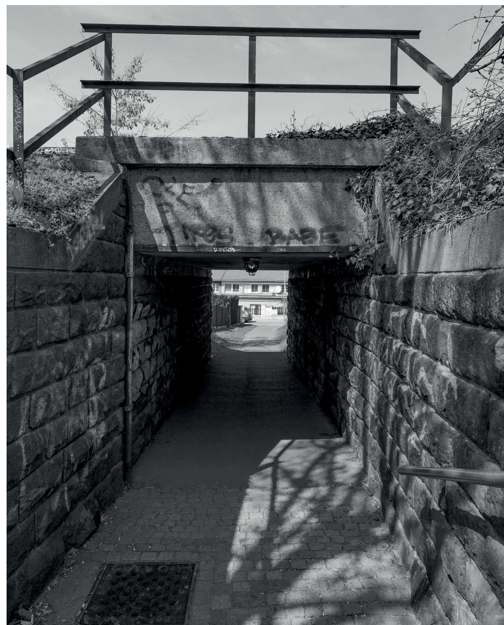
PROPUSTEK – PODCHOD U ULICE NA SPÁDU, Z ROKU 1871 (1933 SANOVÁN)
