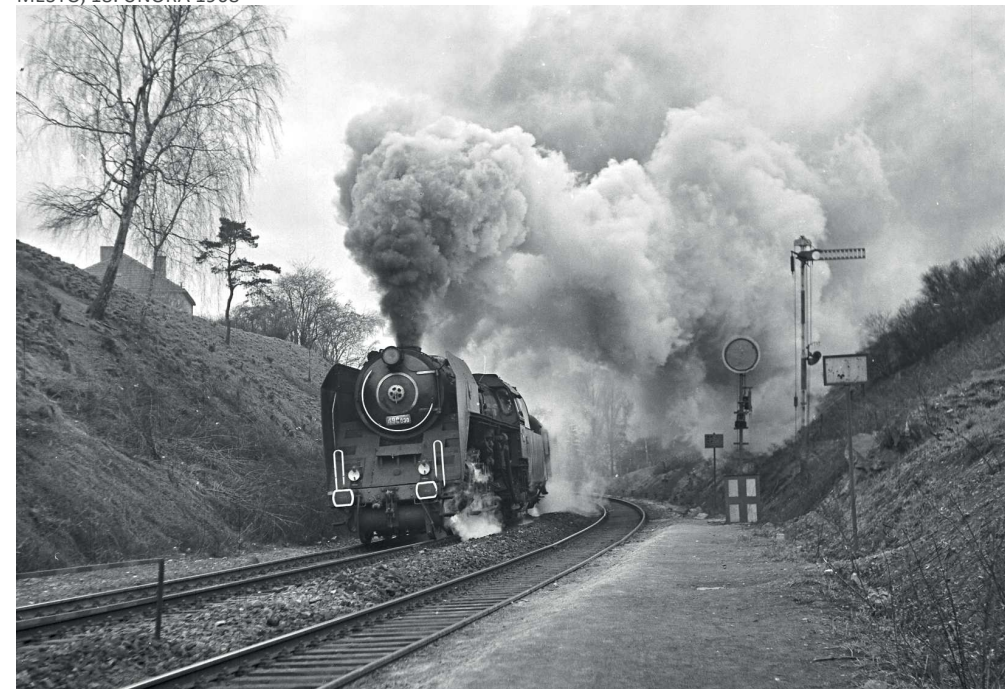
6/ NA KONCI ŠTRAŠNICKÉ ZASTÁVKY BÝVALA OJEDINĚLÁ VZÁCNOST - NÁVĚSTIDLO PRO SMĚR DO VRŠOVIC UMÍSTĚNÉ U PŘEDVĚSTI DALŠÍHO NÁVĚSTIDLA V ODBOČCE ŽELEZNÝ MOST. OSOBNÍ VLAK DO ČESKÝCH BUDĚJOVIC, 13. DUBNA 1969.
