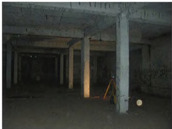
INTERIÉR - ŽELEZOBETONOVÁ KONSTRUKCE PODNOŽE
