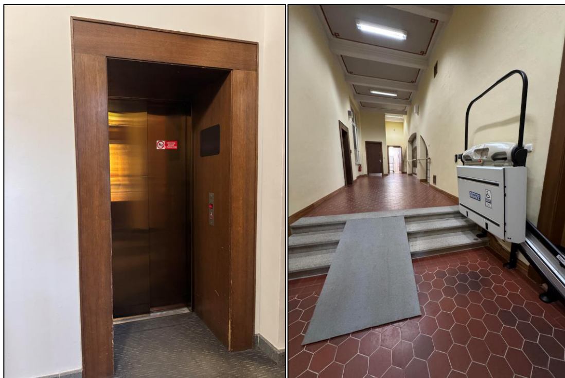
(výtah v přízemí budovy, vchod z ul. U Radnice; plošina a rampa v 1. patře)
