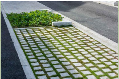
Propustná žulová nebo betonová dlažba u parkovacích stání
